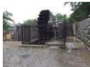
<常西公園小水力発電所>
